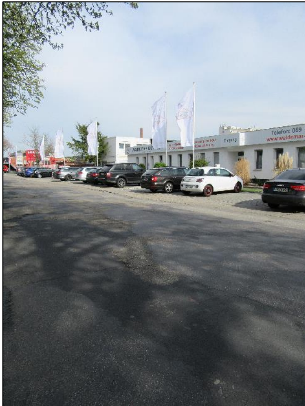
Abbildung 17: Orber Straße 17, Blick nach Südosten, Bauende
