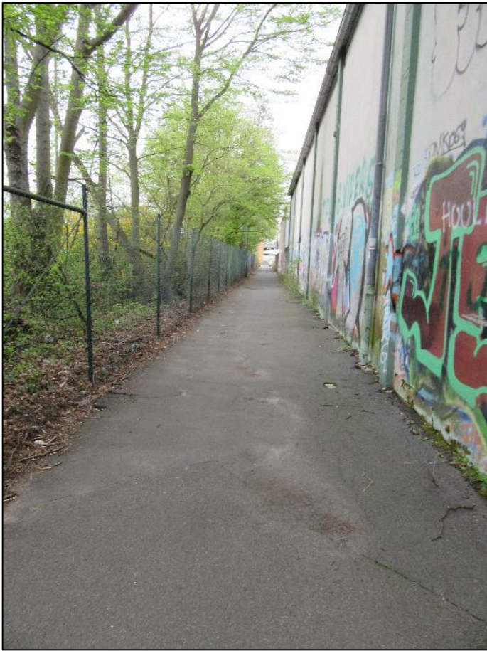
Abbildung 6: Bahnseitenweg, auf Orber Straße zulaufend
