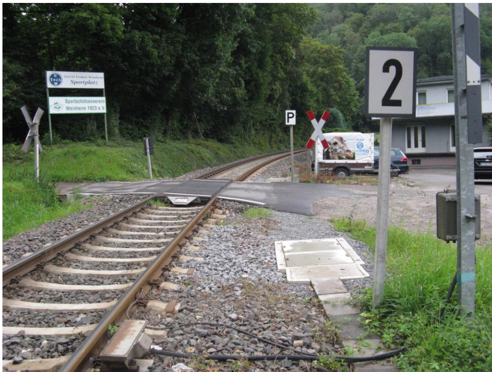
Blick vom BÜ in Kilometrierung in Richtung Fürth, im Vordergrund neuer Kabelschacht, im Hintergrund Parkplatz und Bebauung Quadrant IV
