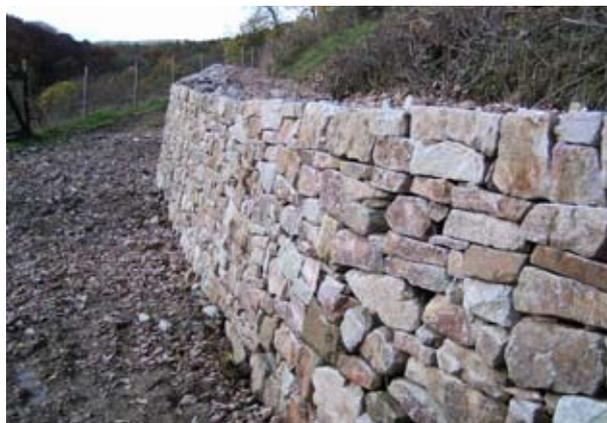
Frisch sanierter, fugenreicher Abschnitt der Trockenmauer im NSG „Sommerberg bei Frauenstein“ (Foto: J. Schmitz)
