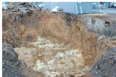
**Abb. 2:** Baugrube nach Ausbau einer Abscheideranlage (© RP Darmstadt)
