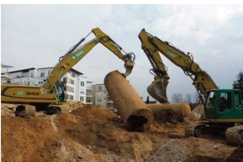
**Abb. 1:** Ausbau eines Heizöltanks (© RP Darmstadt)
