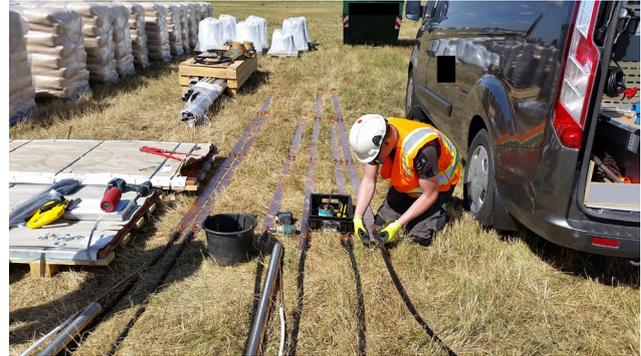
Vorbereitung der Kupferelektroden für ERH (© RP Darmstadt)
