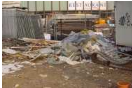
„Baustelle mit gemischten Bauabfällen“
