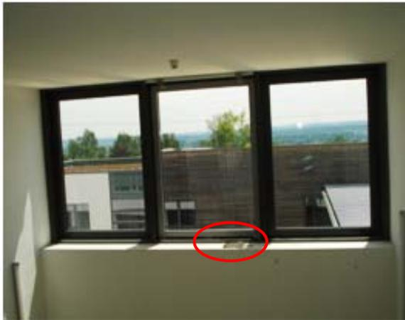
**Abbildung: Fenster mit durchgetretener Gipskartonplatte**
