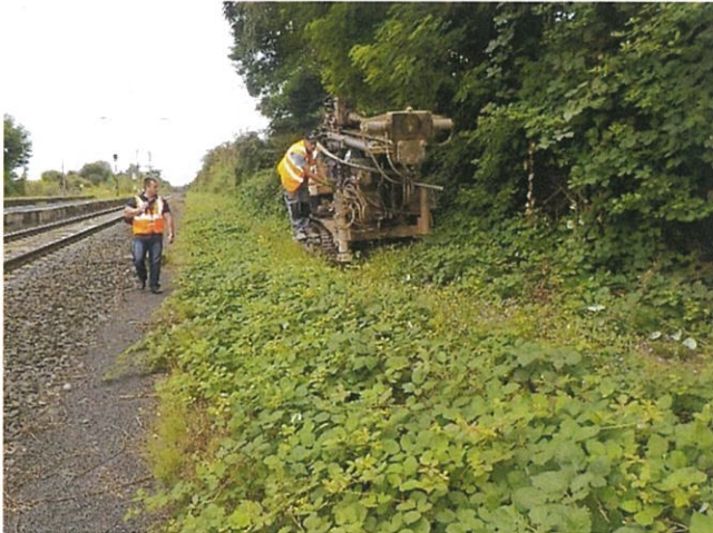
Bild 3: Antransport Bohranlage zur BK 1
