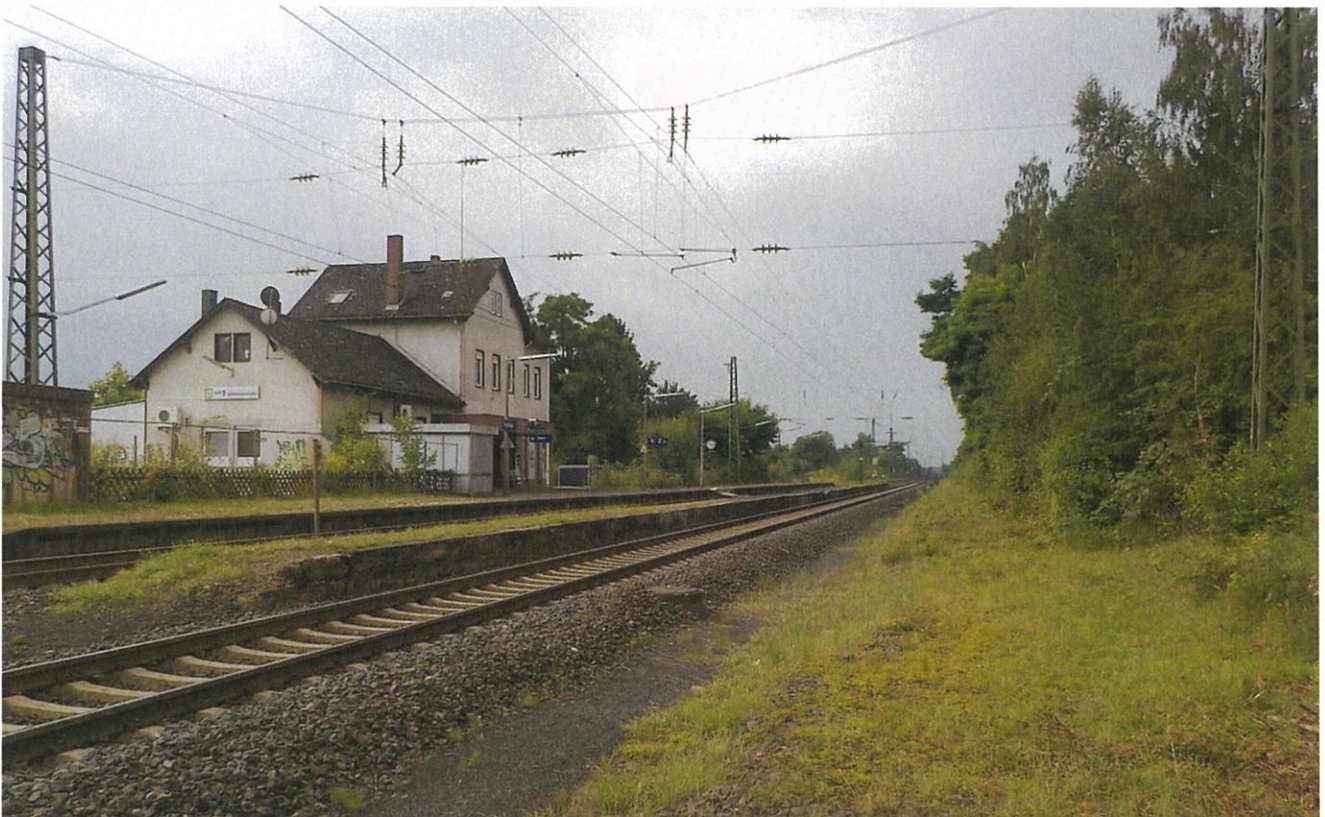
Bild 2: Übersicht Baufeld, Blickrichtung Süd
