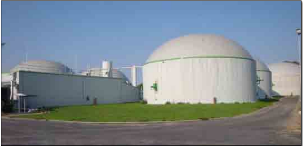
Abb. 6 : Fermenteranlagen; Quelle: juwi
