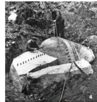
Die Steinbrech- und Steinhauerarbeit wurde bis zum Beginn des 20. Jahrhunderts ausschließlich von Hand durchgeführt - größere Stücke wurden zuerst mit Schwarzpulver gesprengt und dann gespalten, früher von Hand mit Hammer und Spaltmeißeln (Punchetten), später kam der Pressluftmeißel hinzu.
