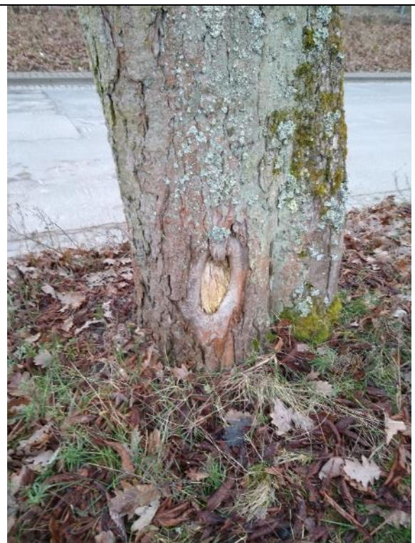
Roskastanie 20 Cooperstr.: Rindenschaden
