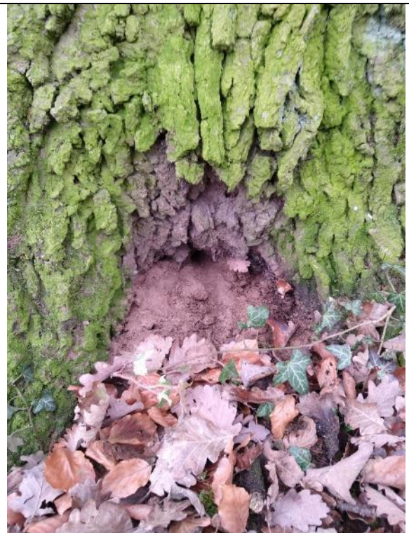
Traubeneiche 33 Cooperstr.: Stammschaden
