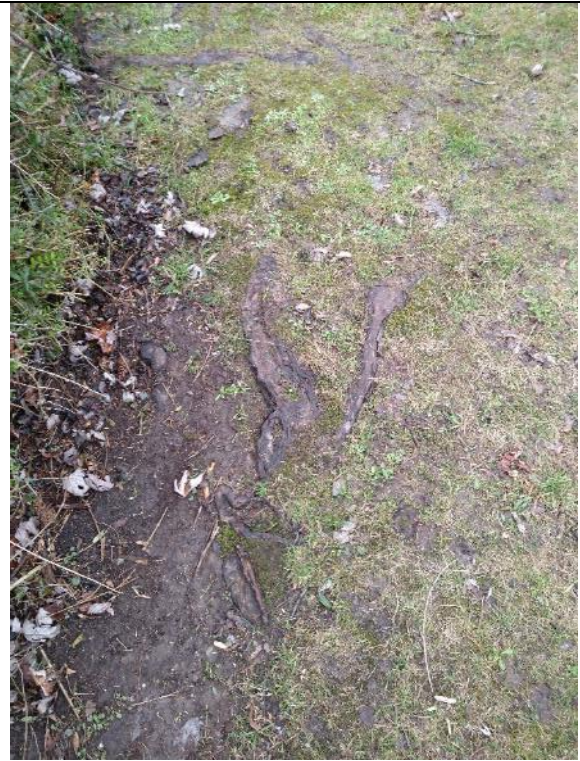
Silberhorn 32B Ludwigshöhstr.: Wurzelschäden
