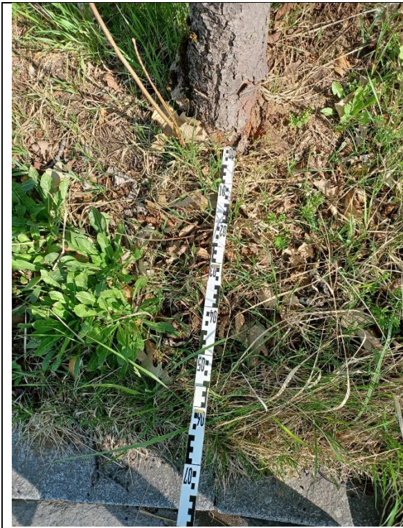
Nr. 13 Cooperstraße: Baumumfeld
