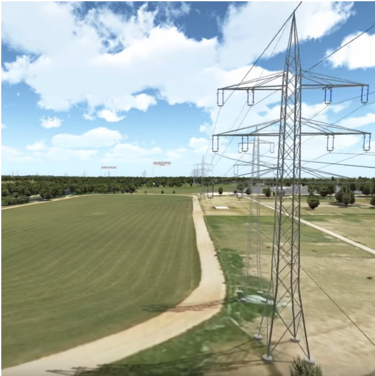
Abbildung 9-2: Fotomontage der Neubauleitung im Vergleich zur Rückbauleitung (Neubaumast Nr. 1012 im Vordergrund, Rückbaumast Nr. 12 in hellgrau dahinter; SYNA 2021A)
