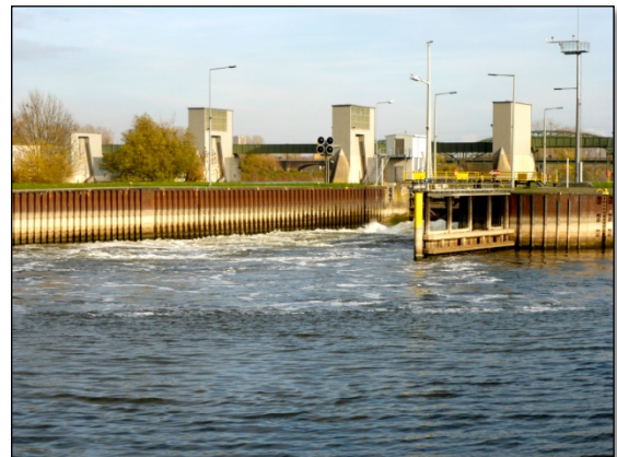
Abb. 6a: Auslaufbereich der rechten Schiffschleusen-kammer Staustufe Kostheim beim Öffnen des Schützes.
