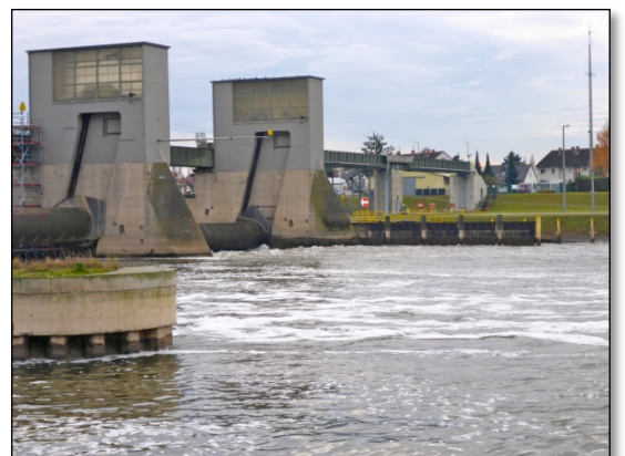
Abb. 6b: Angehobene Wehrwalze (um 62 cm) auf der linken Uferseite; Durchfluss 118 m 3 /s (22.11.2016).
