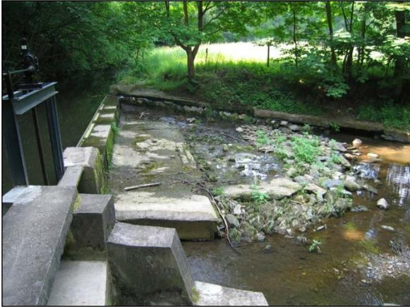
**Abb. 12:** Wehr der WKA zwischen Lorsbach und Eppstein mit ungenügender Mindestwasserdotierung; im Hintergrund der veraltete Fischpass (Sommer 2007).
