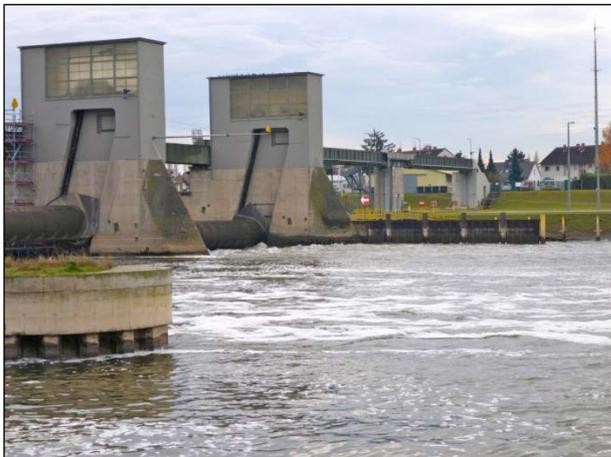
**Abb. 23b:** Angehobene Wehrwalze (um 62 cm) in Kostheim auf der linken Uferseite; Abfluss 118 m<sup>3</sup>/s (22.11.2016).
