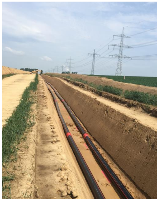
Auslegen der Kabelschutzrohre
