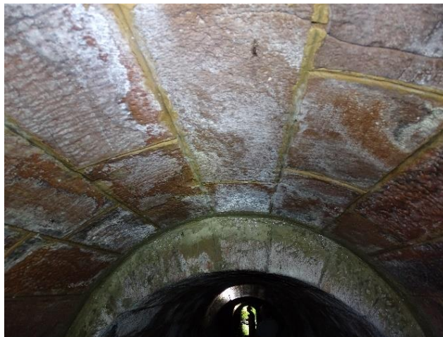
Abb. 37: An den zehn vorhandenen Rundbögen werden je zwei Deckensteine an der Decke angebracht.
