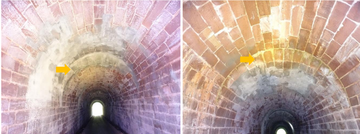
Abb. 6: Mögliche Orte für Vorsatzmauern mit tiefen Spalten als Sanierungsmaßnahme im Risikomanagement.
