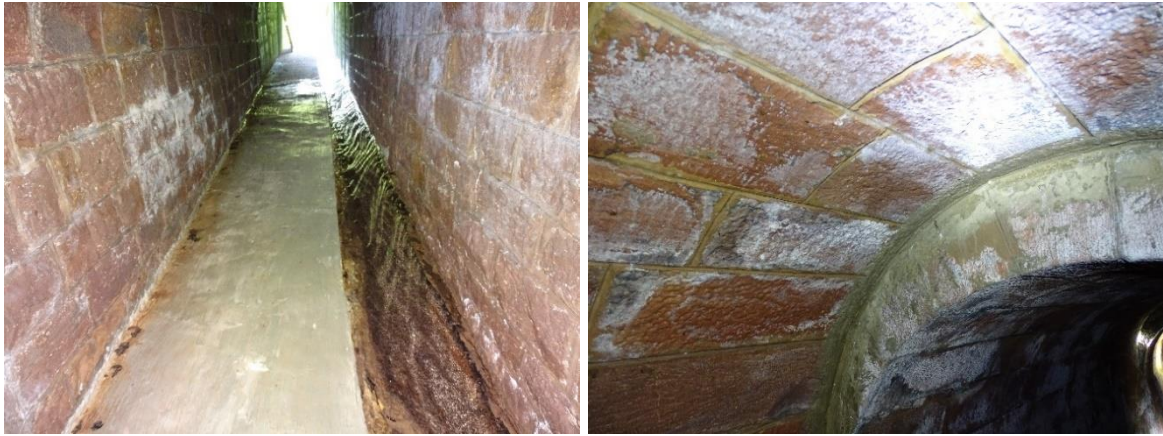
Abb. 36: Zustand nach Sanierung mit Ausbetonierung des Gewässerverlaufs.
