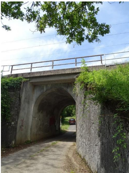
Abb. 10: Außenansicht (Blick von Südost).
