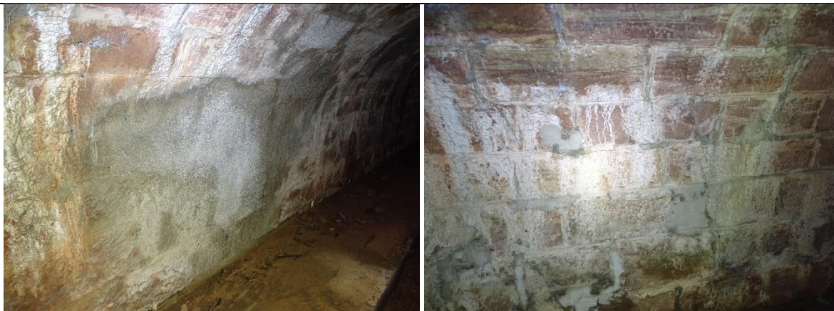
Abb. 53: Beispiele flächig verputzter Mauerwerksausschnitte mit vormals potenziell geeigneten Fledermausverstecken.
