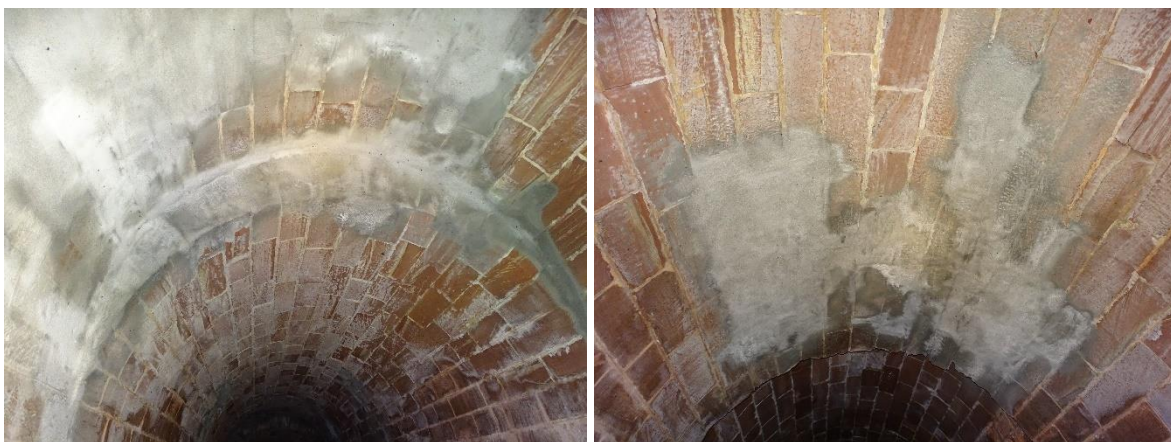
Abb. 5: Beispiele für den Verschluss von Gewölbespalten, die von Fledermäusen als Winterquartier genutzt wurden. Über die hellen Mörtelschichten können die Flächen und Längen der verschlossenen Spalten bilanziert werden.
