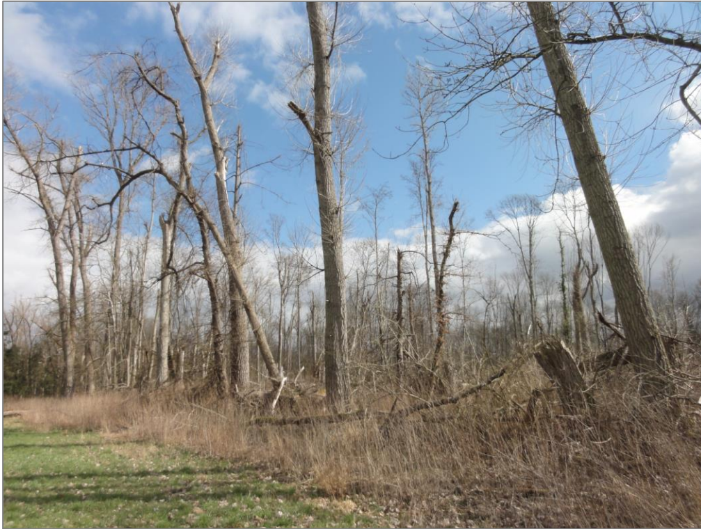
Abb. 14 Sturmschäden im NSG Kortenbach bei Froschhausen nahe dem Wernigraben (Aufnahme 16.03.2021)
