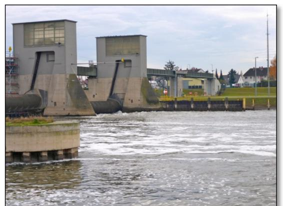
**Abb. 6b:** Angehobene Wehrwalze (um 62 cm) auf der linken Uferseite; Durchfluss 118 m<sup>3</sup>/s (22.11.2016).
