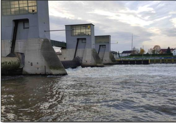
**Abb. 6c:** Angehobene mittlere Wehrwalze (um ca. 200 cm) in Kostheim am 23.11.2017, 9:20 Uhr; Abfluss ca. 600 m<sup>3</sup>/s (Foto: T. SEUFERT).
