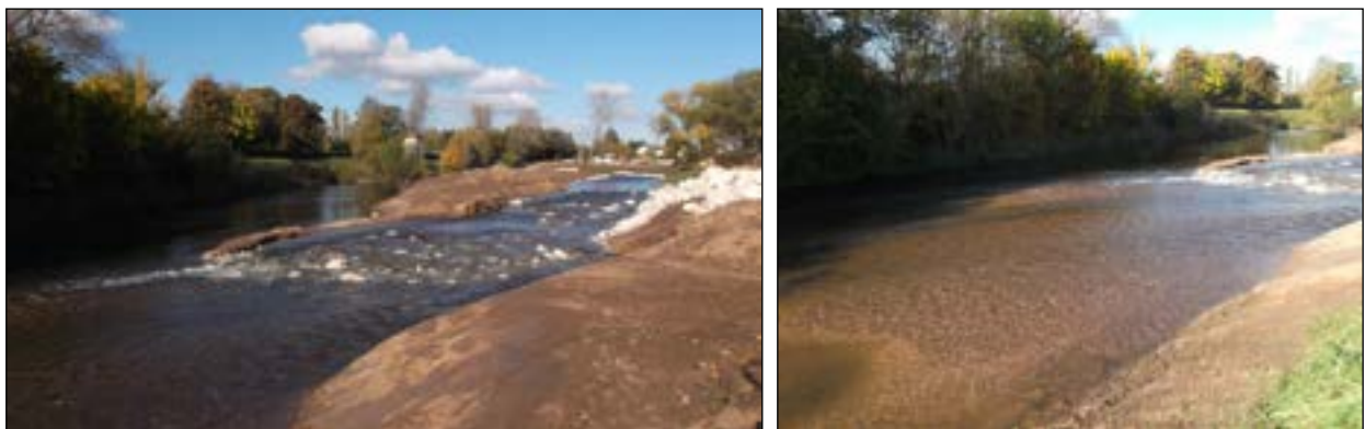
Abb. 1a: Wehr Höchst (Unterlauf Nidda) nach Umbau im Oktober 2012 (Fotos: M. GLAUCHE).
