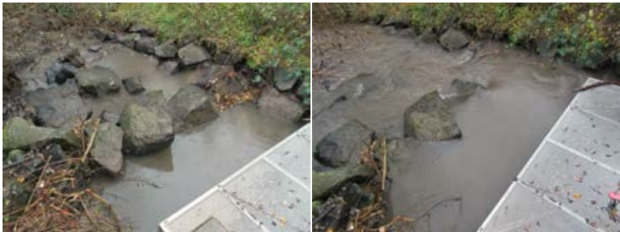
Abb. 21a: Wasserspiegel vor (links) und nach (rechts) dem Heben und Säubern der Reuse.
