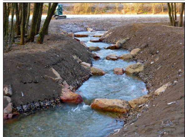
Abb. 11: Oben: Wehr „Lederfabrik“ direkt oberhalb Lorsbach, Oberwasser mit verlandetem Mühlgraben im Sommer 2007 Unten: Umgehungsgewässer kurz vor der Fertigstellung im Dezember 2016
