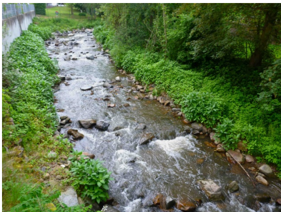
Abb. 9b: Ehemaliges Wehres Obermühle zwei Jahre nach der Umgestaltung in eine naturnahe Sohlengleite; mittlerer Abschnitt im Sommer 2014.
