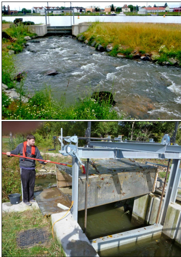
Abb. 19: Wartungsarbeiten an der Aufstiegsreue am Einlauf des Umgehungsgerinnes am Wasserkraftwerk Kostheim (Main).
