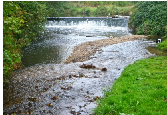
Abb. 8a: Schwarzbach; Auslauf des Umgehungsgerinnes (Pfeil) am Wehr Bonnemühle im Okt. 2008 (oben); am 1.10.2010 nach der Räumung des Einlaufbereichs (unten).
