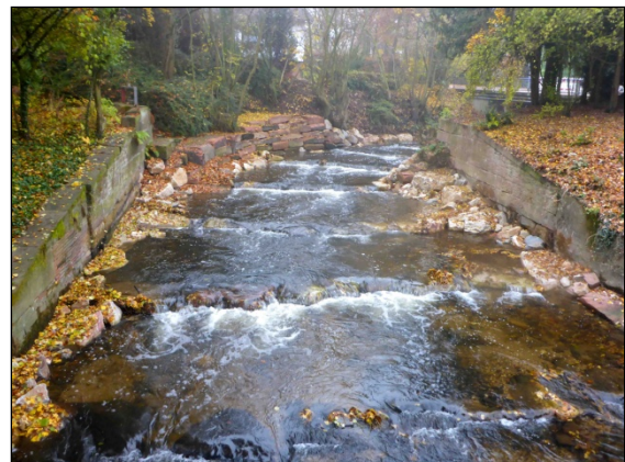
Abb. 14b: Sohlengleite am ehemaligen Wehr am Freibad Hattersheim im Oktober 2018.
