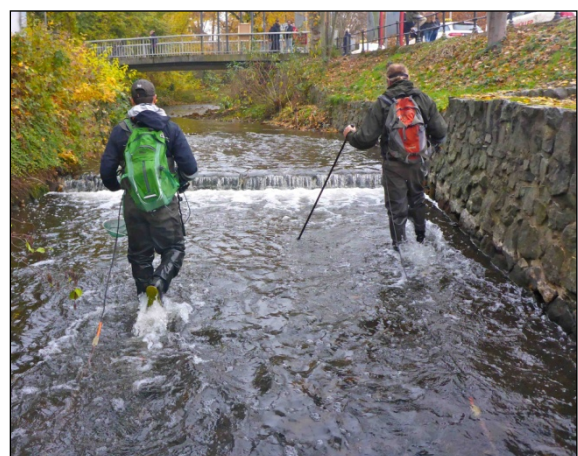
Abb. 14c: Zwei Sohlenschwellen auf Höhe Busbahnhof Hofheim behindern noch immer den Aufstieg großer Individuen.
