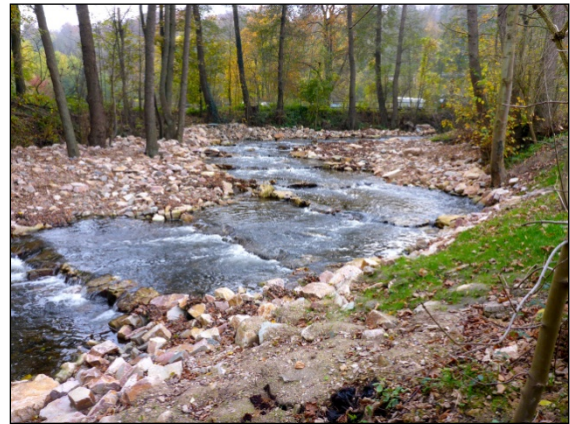
Abb. 10: Im Herbst 2017 umgestaltetes Wehr Wiesenmühle am oberen Ortsrand von Hofheim.
