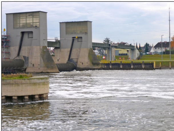
Abb. 23b: Angehobene Wehrwalze (um 62 cm) in Kostheim auf der linken Uferseite; Abfluss 118 m 3 /s (22.11.2016).
