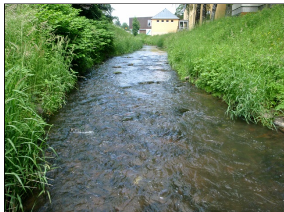
Abb. 6: Begradigter Abschnitt auf Höhe der Martin-Luther-Schule in Rimbach, Besatzstrecke Wz_Ri 1
