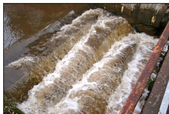
Rampe Schlaadt bei hohem Abfluss am 12.11.2010
