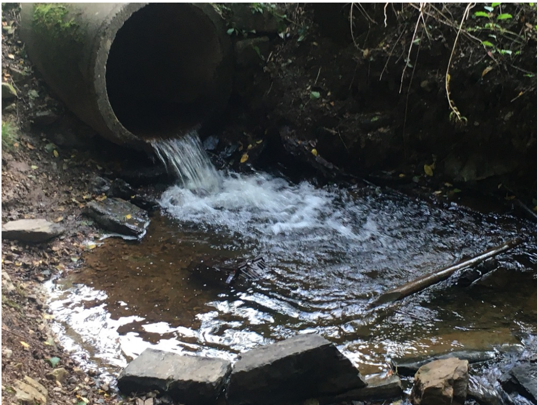
Abbildung 19: Reuse im Kolk unter dem Rohrdurchlass Walkmühlstraße, PrSt R3 (Photo R. Hennings, IMG_0575, 1.9.2023)
