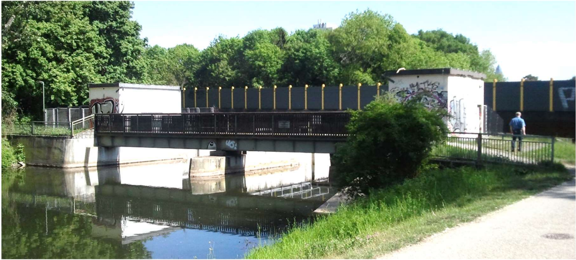
Abbildung 4.11 Hausener Niddawehr (Oberwasser), Aufnahme CDM Smith
