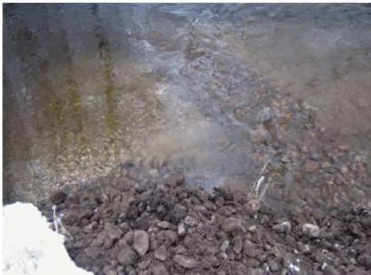
Abbildung 6.3 Lenkbuhne aus Kies und Geröll (Fließrichtung von links nach rechts) [U39]
