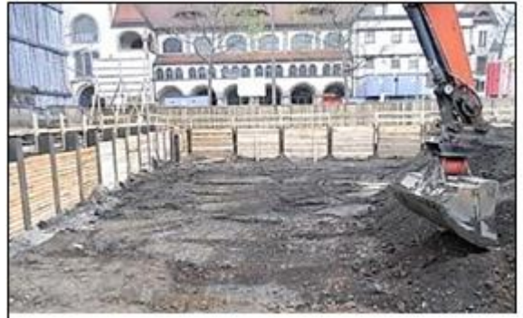
Abb. 4 Schichtenweiser Abtrag, verpflichtend bei baubegleitender KMR
