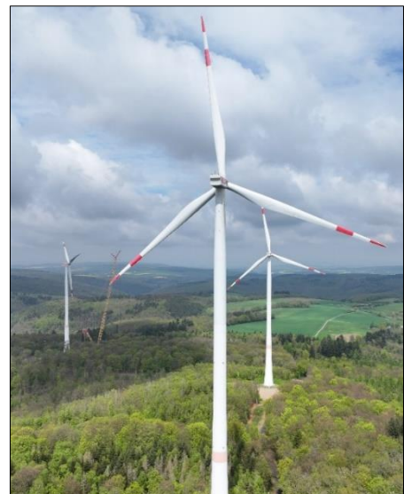
Abbildung 9: Aufnahme der Drohne, Windenergieanlagen in Hohenstein (© RP DA IV/Wi)
