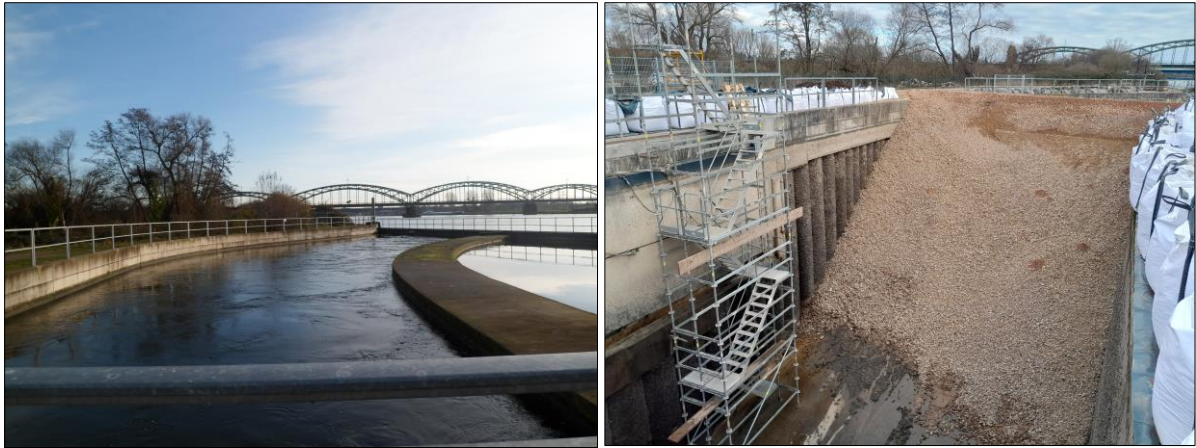
Abbildung 2: Trockenlegung Einlaufkanal (© RP DA IV/Wi 41.2)
