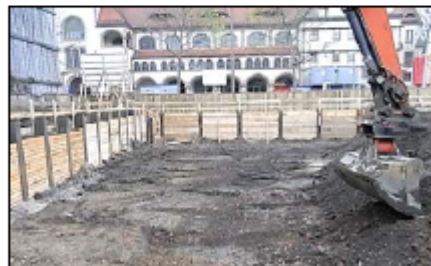
Abb. 4. Schichtenweiser Abtrag, verpflichtend bei baubegleitender KMR
