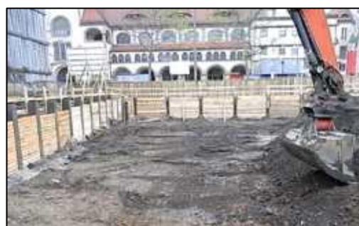
Abb. 4. Schichtenweiser Abtrag, verpflichtend bei baubegleitender KMR
