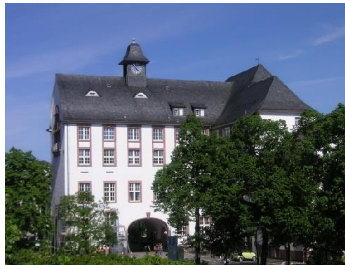
2011 Haus 9 Mit Erweiterung Labore 2012/13
